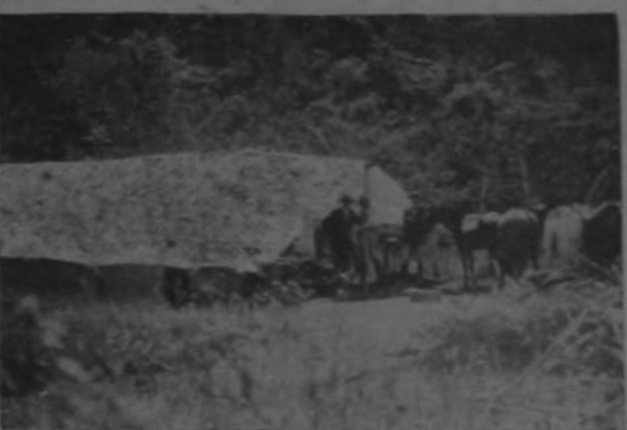
Campamento provisional y sitio probable donde se construirán las oficinas.
